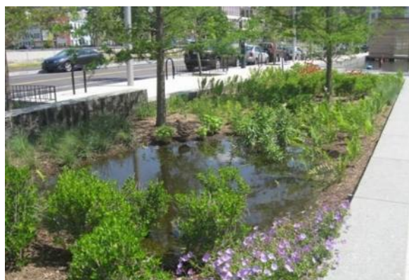
Рисунок 27 – Примеры устройства дождевых садов
