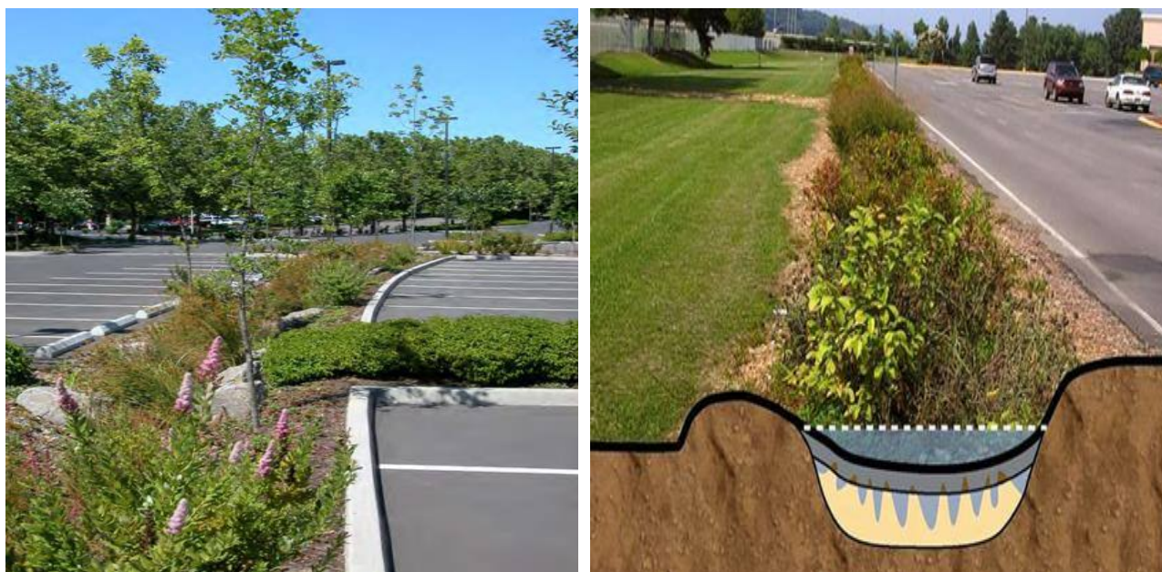
Рисунок 11 – Примеры устройства растительных каналов
