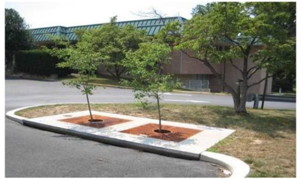
Рисунок 37 – Примеры устройства коробчатых фильтров с посадкой деревьев
