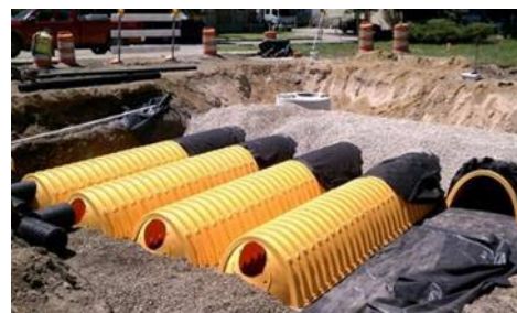
Рисунок 19 – Примеры устройства подземных накопителей
