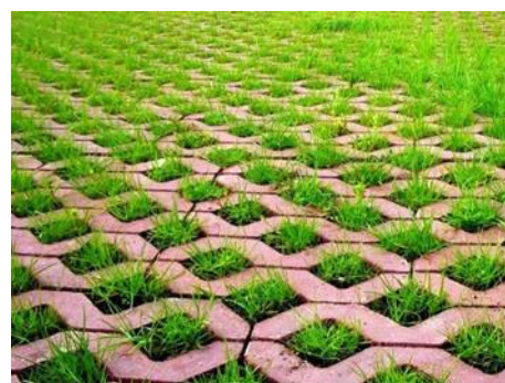
Рисунок 17 – Примеры устройства водопроницаемых покрытий
