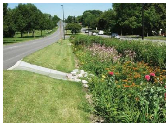
Рисунок 27 – Примеры устройства дождевых садов
