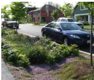
Рисунок 24 – Примеры устройства фильтрующих траншей
