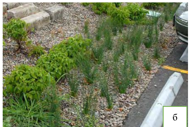
Рисунок 7 – Примеры устройства фильтрующих полос (а – фильтрующая полоса естественного происхождения, б – фильтрующая полоса искусственного происхождения)
