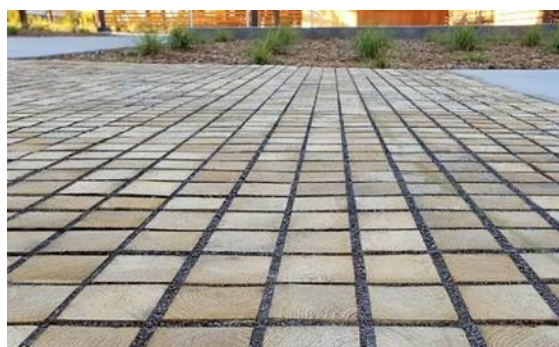
Рисунок 17 – Примеры устройства водопроницаемых покрытий
