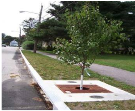
Рисунок 37 – Примеры устройства коробчатых фильтров с посадкой деревьев
