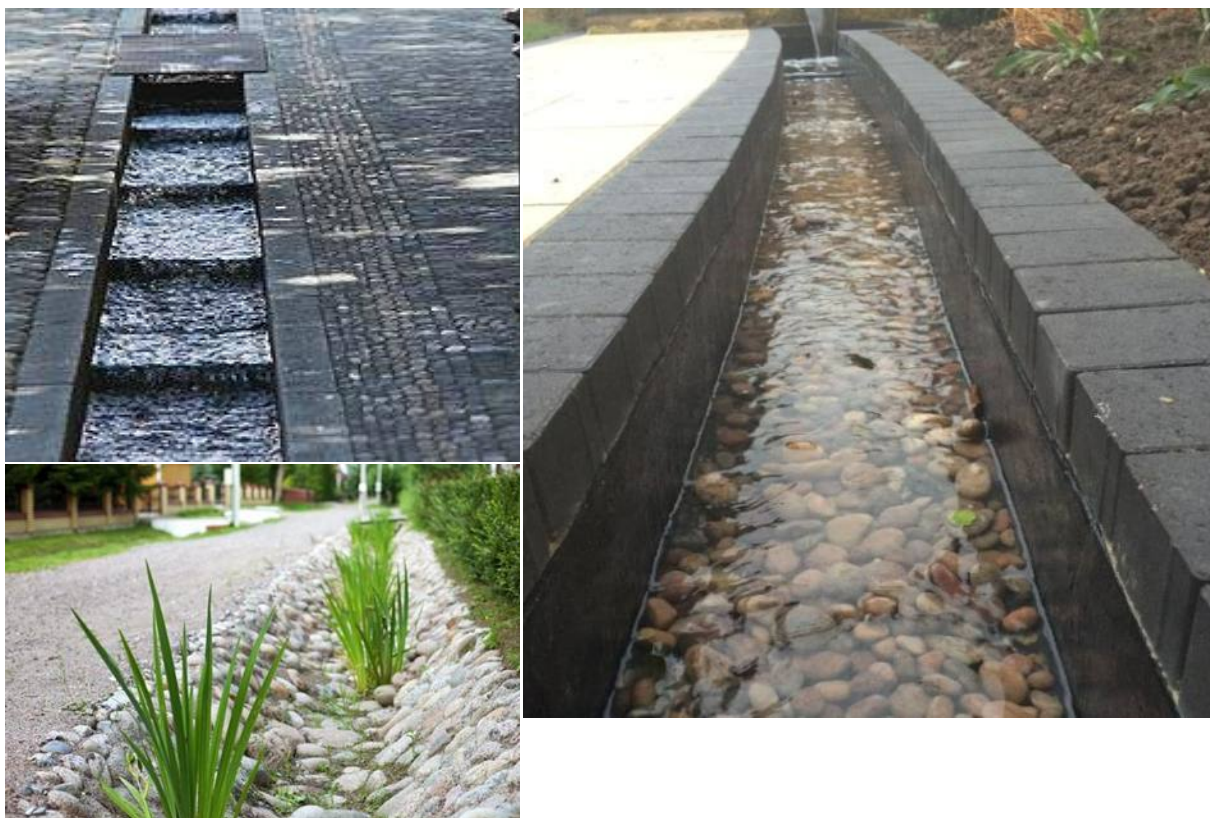
Рисунок 16 – Примеры устройства придорожного канала
