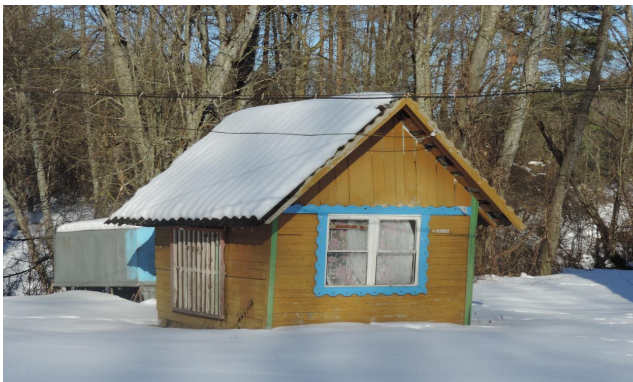
Здание неустановленного назначения, ДОМИК СТОРОЖА, 231/С-8973
